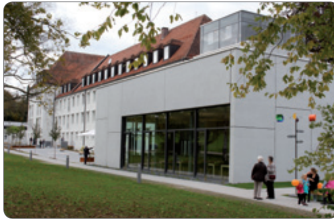
Die neue Günztalklinik Allgäu mit dem neu errichteten Eingangsbereich (vorne) und dem frisch renovierten Hauptgebäude (dahinter),
